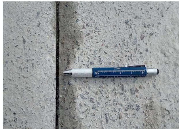
Рисунок 4 – Ручне затирання поверхні цементобетонного покриття (а) та вигляд цементобетонного покриття готового до експлуатації (б)
