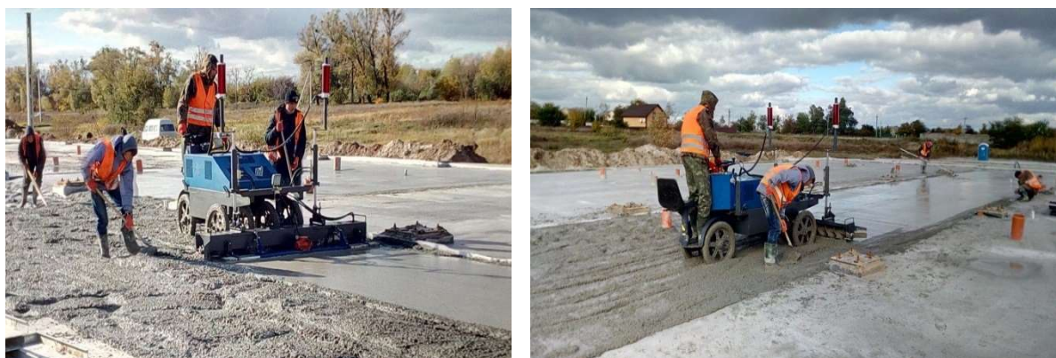
Рисунок 3 – Влаштування цементобетонного покриття із пластичної суміші бетоноукладачем MANIPAV-2000
