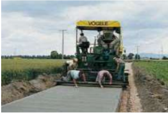
Рисунок 1 – Бетоноукладач з ковзною опалубкою при укладанні цементобетонного покриття для місцевих доріг
