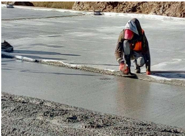
Рисунок 4 – Ручне затирання поверхні цементобетонного покриття (а) та вигляд цементобетонного покриття готового до експлуатації (б)
